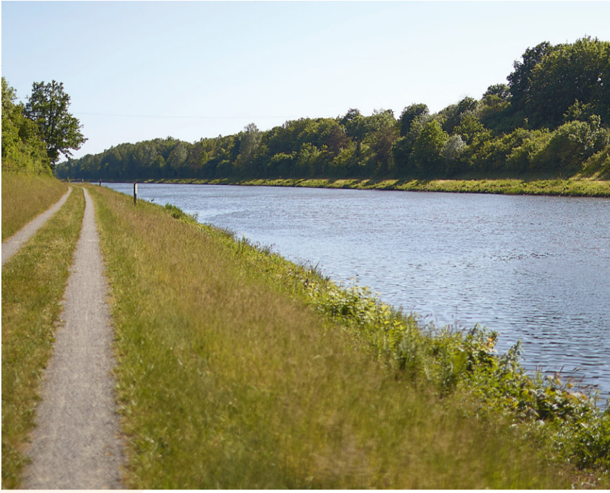
Auf dem Weg von Schleswig-Holstein nach Süddeutschland muss der SuedWestLink mehrere Gewässer unterqueren.
